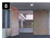
Ościeżnice stalowe z wysokiej jakości drewnianymi wielofunk- cyjnymi drzwiami Schörghuber
